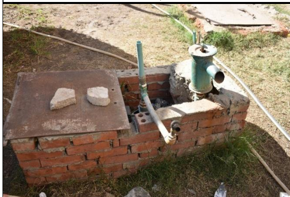
مثال على الحفاظ على المياه – بئر استخراج المياه الجوفية
