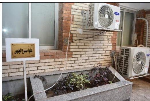
صور لاعادة إستخدام مياه التكييفات لرى النباتات
