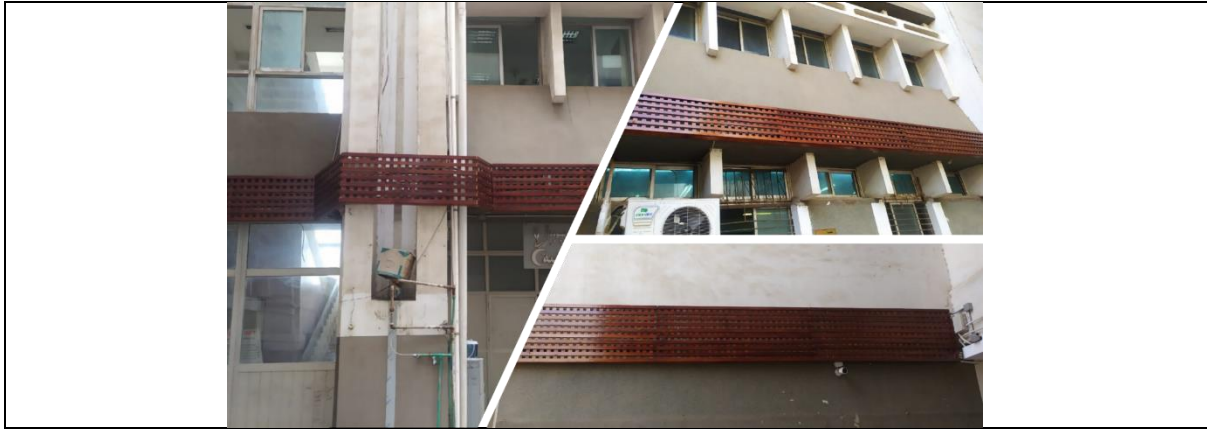
إعادة تدوير الخشب واستخدامه في تجليد المباني بالمشغولات الخشبية
