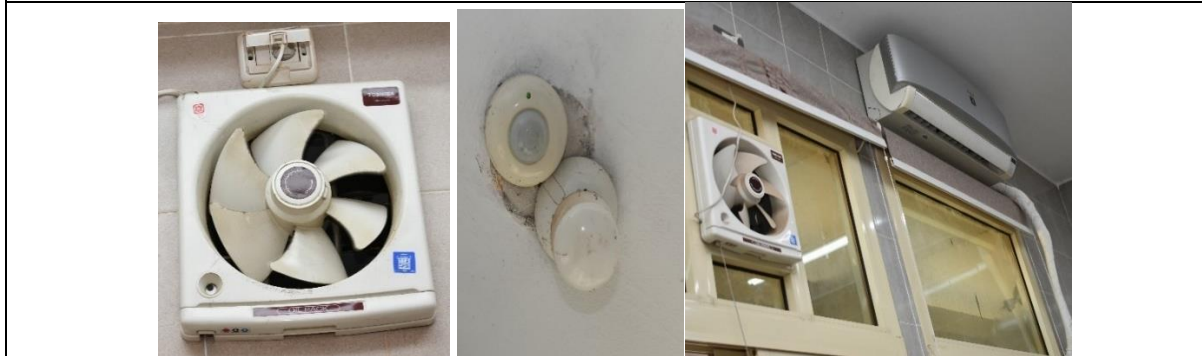
صورة 26: توضح حساسات الاضاءة وبعض الصور لأجهزة تنقية الهواء مثل الشفاطات والتكييفات
